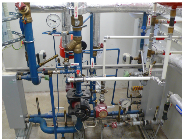
Joonis 3.2 Säätumarketi soojusvahetitega soojussõlm
